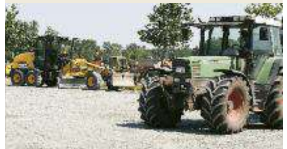
Der Freundeskreis Dobrock-Turnier hat in Eigenregie die Sanierung des Abreiteplatzes am Hauptspringparcours durchgeführt.
